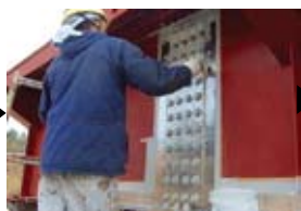
チタン箔の貼り付け 及び CMP チタンプライマー塗装
